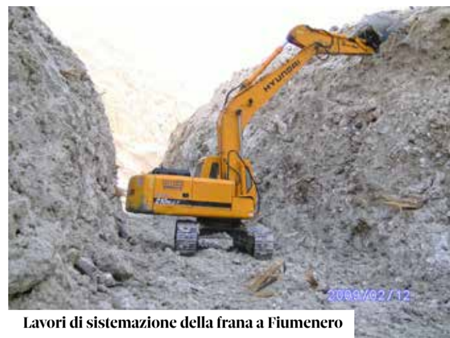
Lavori di sistemazione della frana a Fiumenero
