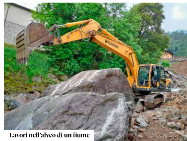
Lavori nell'alveo di un fiume
